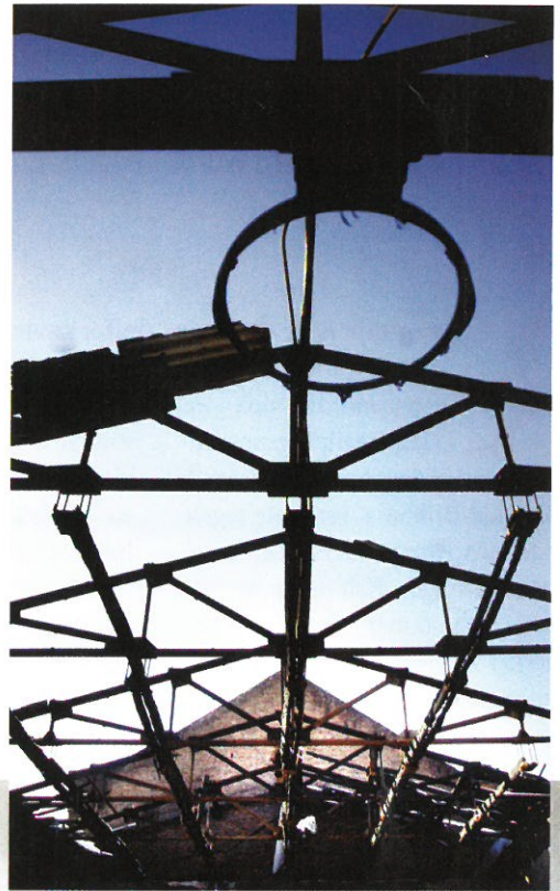
Aan de baskets in de gymzaal werden bommen opgehangen die er op de derde dag de oorzaak van waren dat het dak naar beneden kwam.
